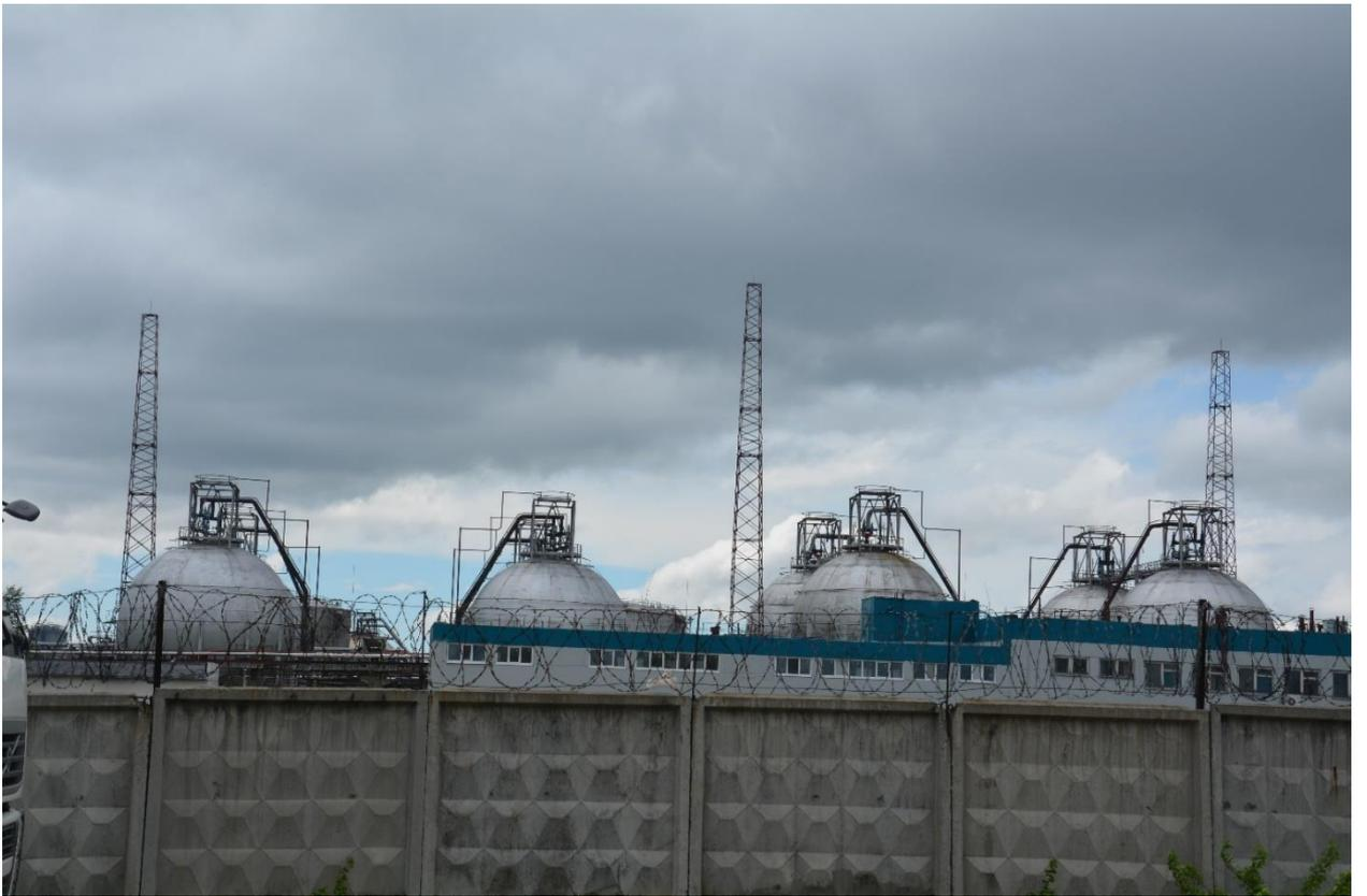
Рисунок Б.2 – Сферические емкости для хранения сжиженного этилена
