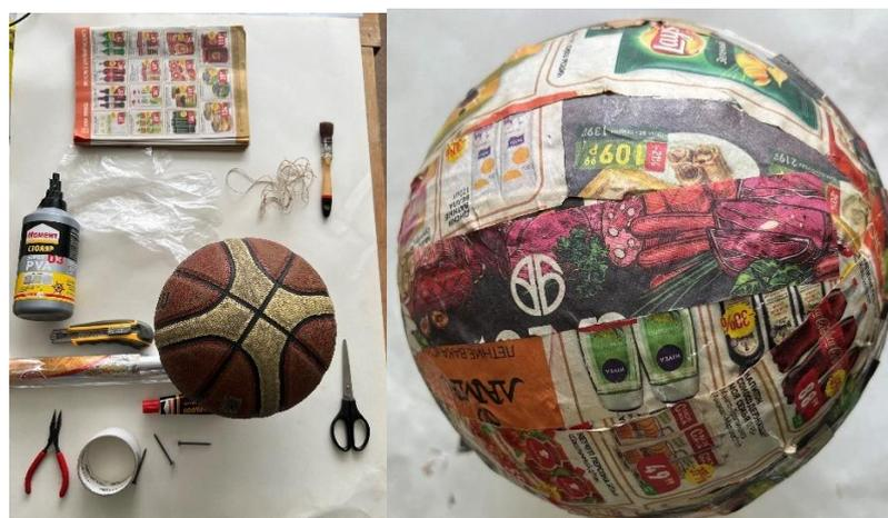
Рисунок 16 – Этапы изготовления сферической антенны а) подготовка; б) изготовление многослойной оболочки из целлюлозы
