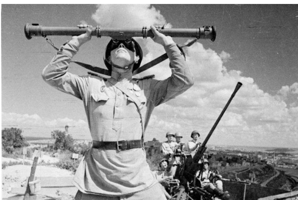
Рис. 10. Однометровый зенитный дальномер ЗДН-1 [12]
