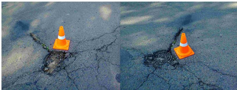
Рис. 2. Стереопара из двух фотографий дорожного конуса на фоне повреждения дорожной поверхности
