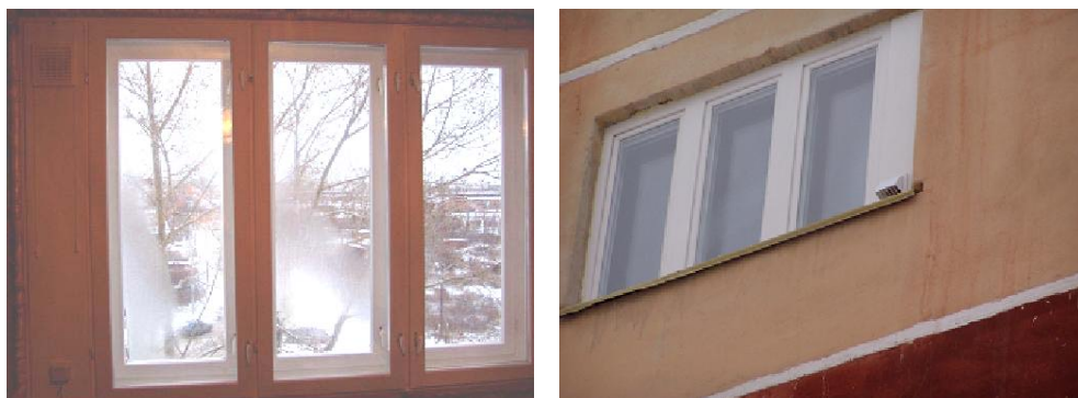
Рис. 8. Шумозащитное окно с воздухообменным клапаном. Вид изнутри и снаружи
