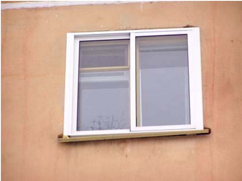
Рис. 3. Накладной оконный шумозащитный экран. Схема устройства и вид снаружи
