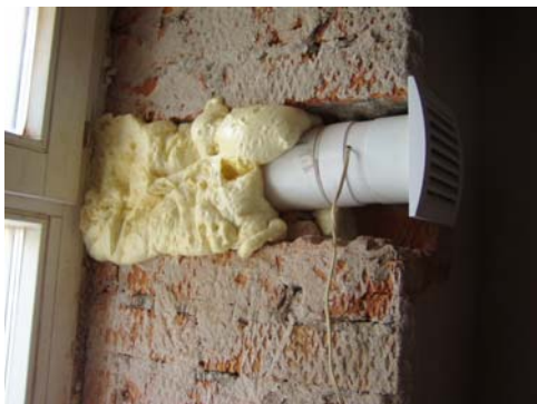
Рис. 5. Воздухообменные клапаны в откосах оконных проемов в процессе монтажа: а – клапан с одним коленом; б – клапан с тремя коленами
