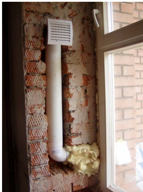
Рис. 5. Воздухообменные клапаны в откосах оконных проемов в процессе монтажа: а – клапан с одним коленом; б – клапан с тремя коленами
